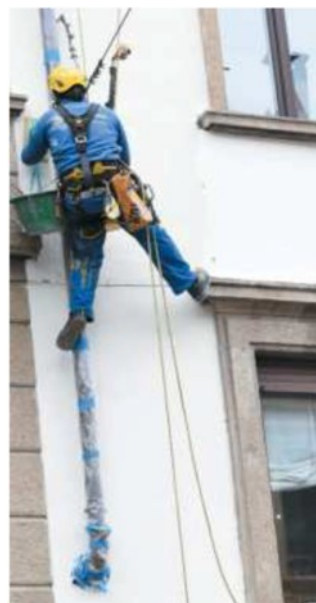
Ristrutturazioni edilizie Operai acrobatici al lavoro (Ansa)
