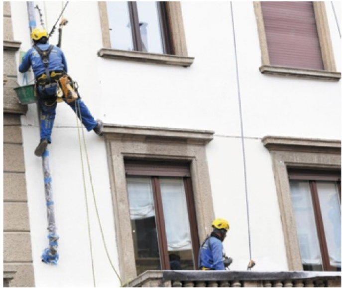
Operai acrobatici ristrutturano la facciata di un palazzo di Milano ANSA
