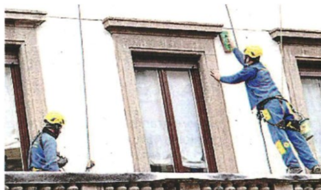
Operai al lavoro per il Superbonus (Ansa)
