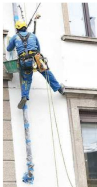
Ristrutturazioni edilizie Operai acrobatici al lavoro (Ansa)
