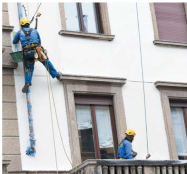
Operai acrobatici ristrutturano la facciata di un palazzo a Milano (Ansa)
