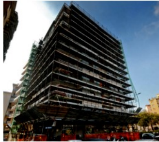
Edificio in ristrutturazione ANSA
